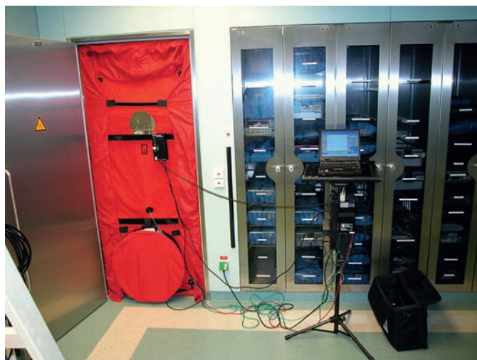
Bild 1. Anlage zur Messung der Luftdichtheit mit dem System Minneapolis BlowerDoor Standard
