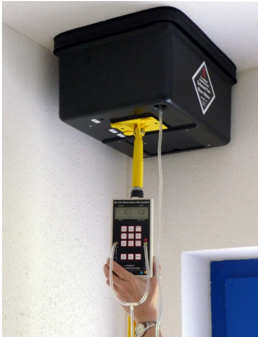
Abb. 7: Die LuftstromBox wird mit dem Teleskopstab gegen die Decke gedrückt und umschließt das Abluftventil
