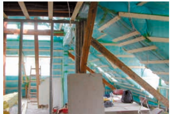
Die luftdichte Ebene ist noch sichtbar und zugänglich (Folie und Holzbauplatte): Der optimale Zeitpunkt für eine BlowerDoor Messung.
