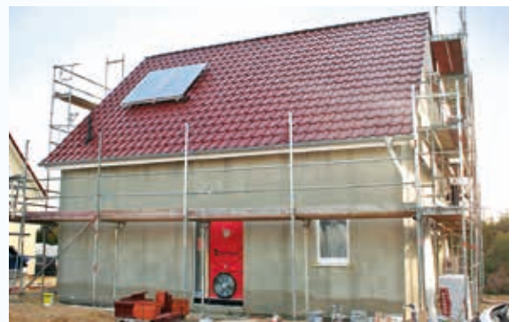
BlowerDoor Messung eines neu gebauten Einfamilienhauses
