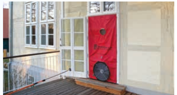
BlowerDoor Messung im Rahmen einer energetischen Sanierung
